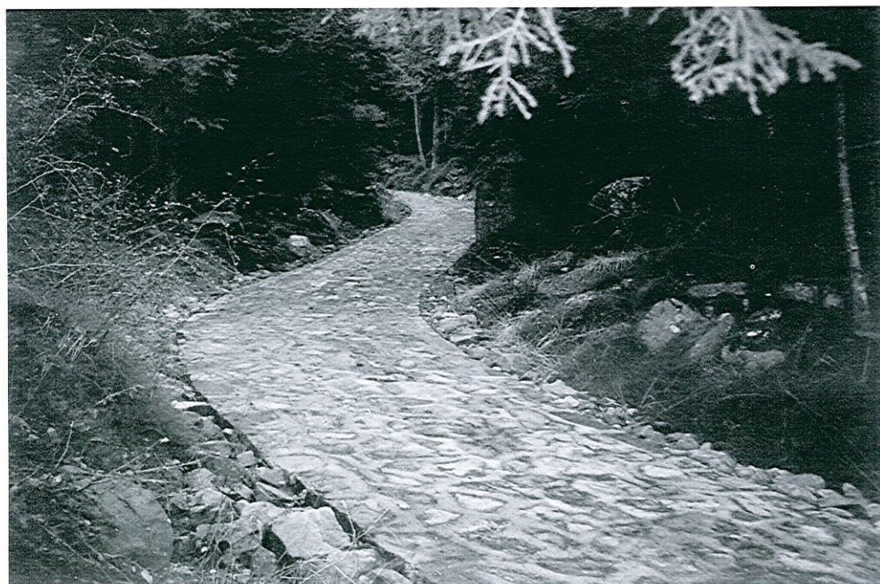
Posa di selciato sulla strada di Barzabal
