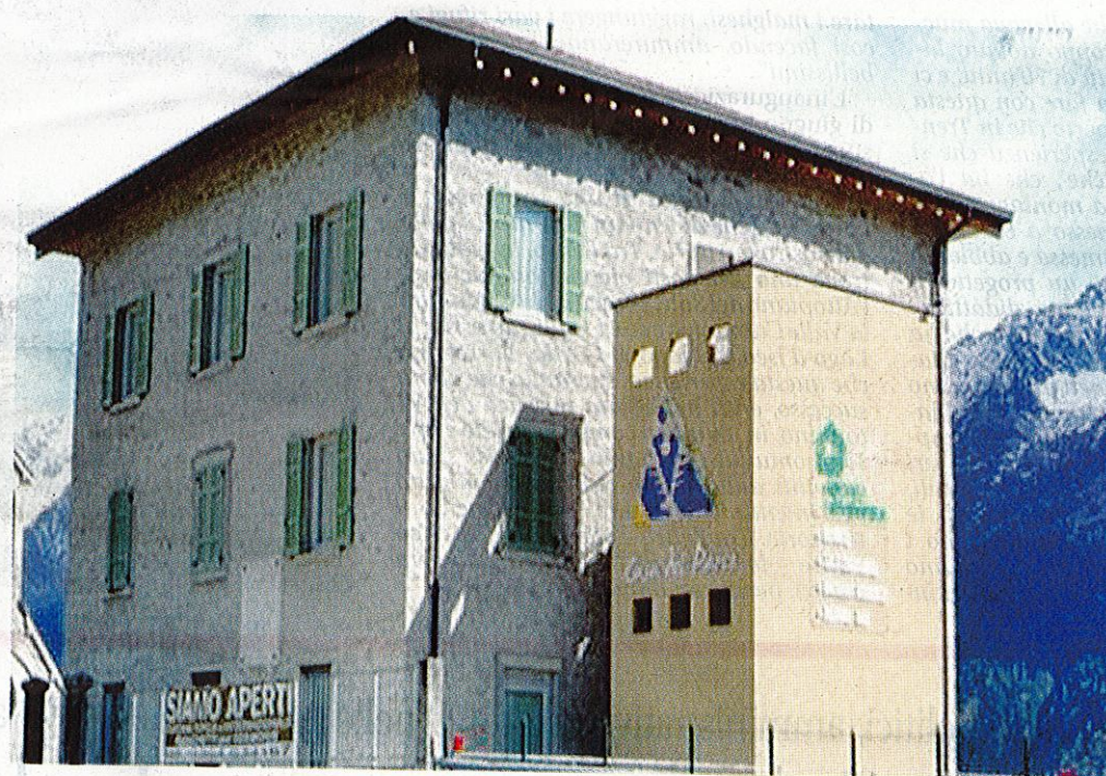
La Casa del Parco tra Cevo e Saviore
