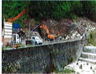
Valsavio: Iniziati i lavori della nuova centralina.
