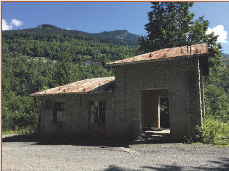
4 Vecchia stazione di partenza della teleferica a Isola
