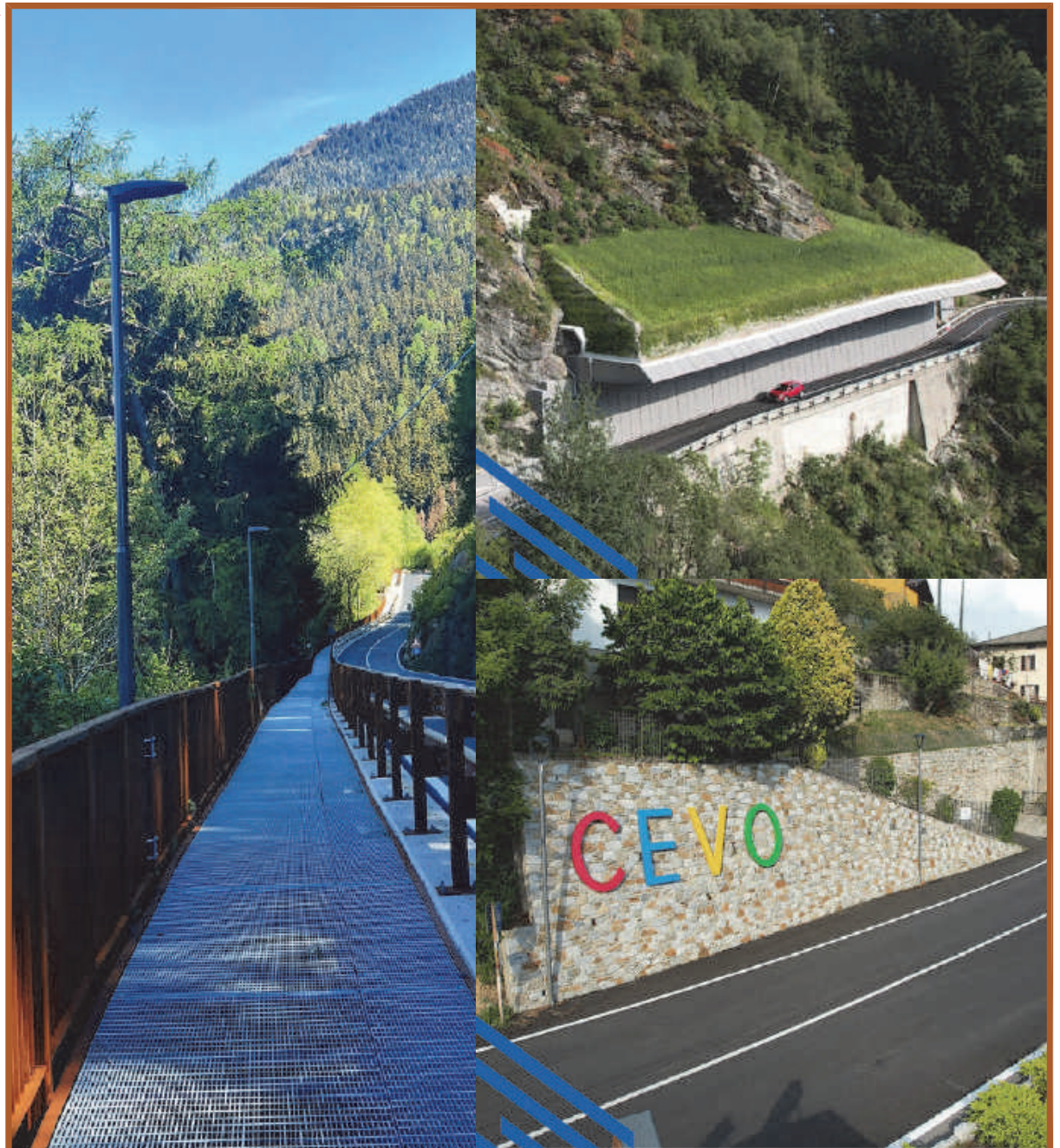
A fianco alcune foto inerenti i lavori
