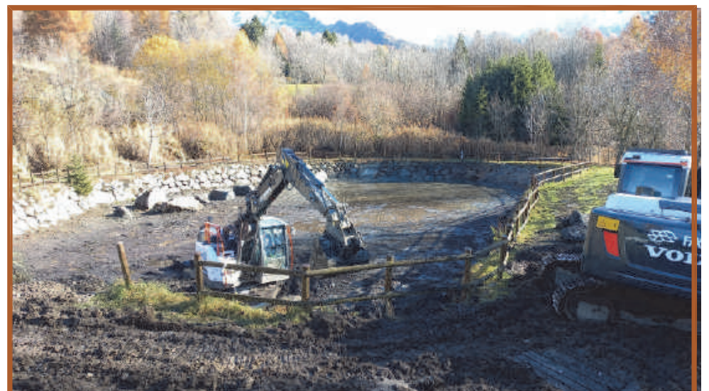
I lavori di scavo in corso al laghetto di Canneto
