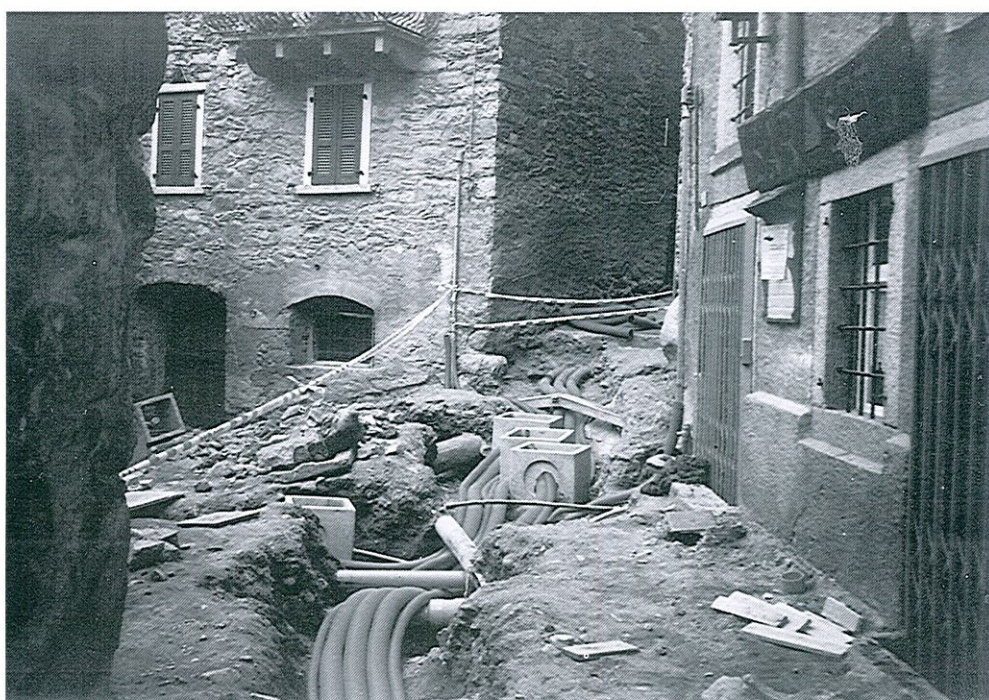
Canalizzazione di nuovi sottoservizi nella piazzetta del Marangù
