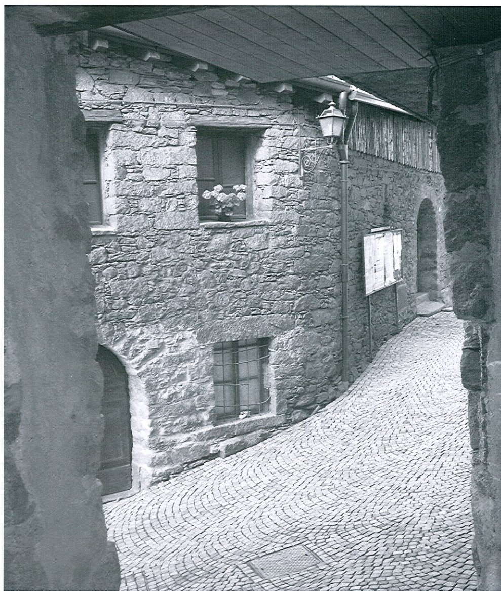
La nuova pavimentazione all'incrocio di Via Adamello con Via Monticelli
