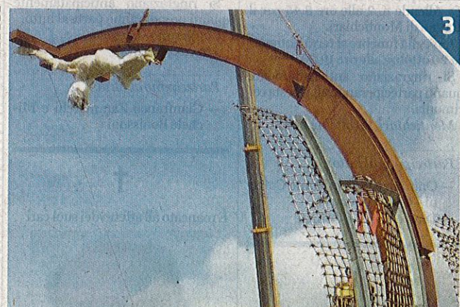
LA NUOVA CROCE. Non senza polemiche dal 2016 il monumento è stato riposizionato con un supporto in metallo a prova di cedimenti e usura.
