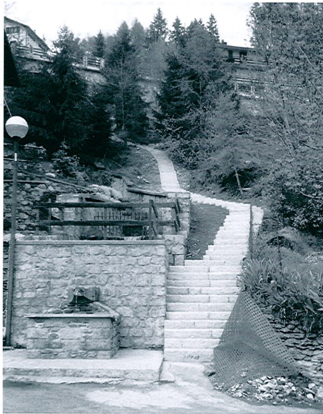
Scala di collegamento Via Castello con Via Pineta, in costruzione
