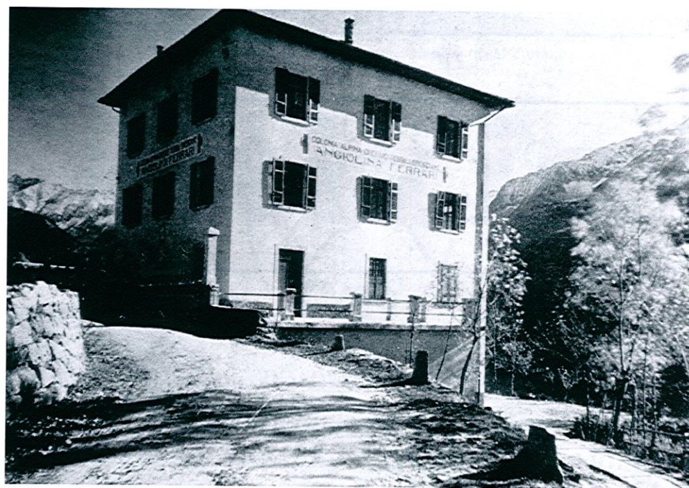
Il fabbricato della Colonia nell'anno 1932
