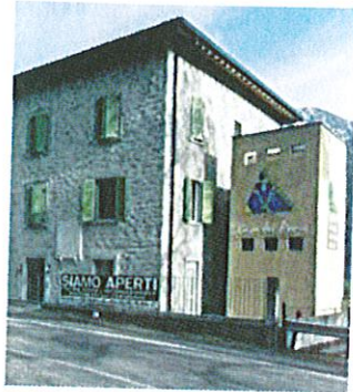
Cevo: La Casa del Parco.
