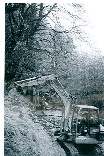
SP. 6: frane in località Plane e montaggio ponte militare in località Zimilina
