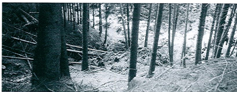
Sorgente Antigola: cedimento strada e frana nella sottostante valle del Coppo
