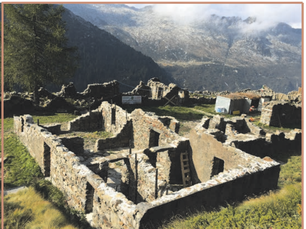
Parte della Caserma Campello a seguito dei lavori di recupero 2016
