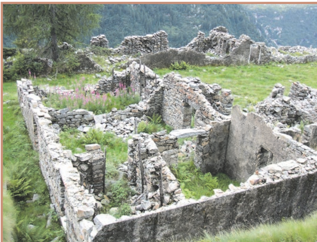
Parte della Caserma Campello prima dell'inizio dei lavori di recupero
