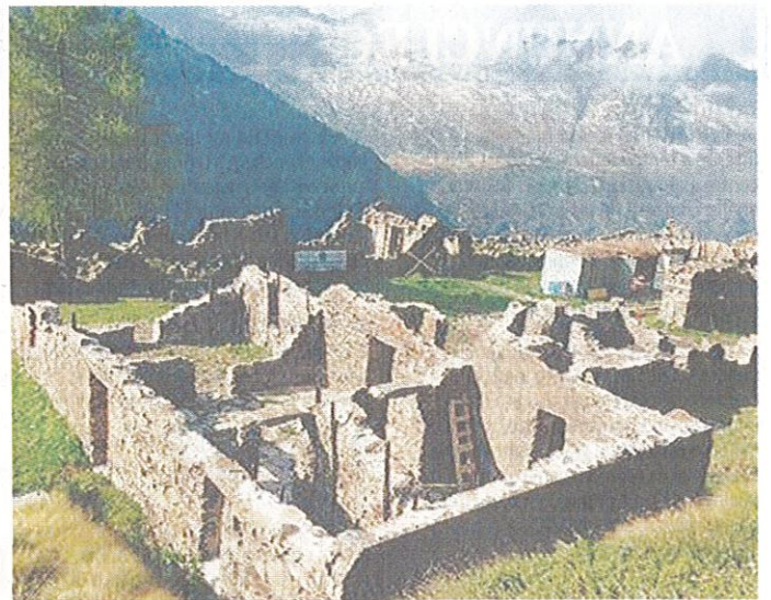
Le macerie recuperate. L'area interessata dai lavori da parte dell'Ana
