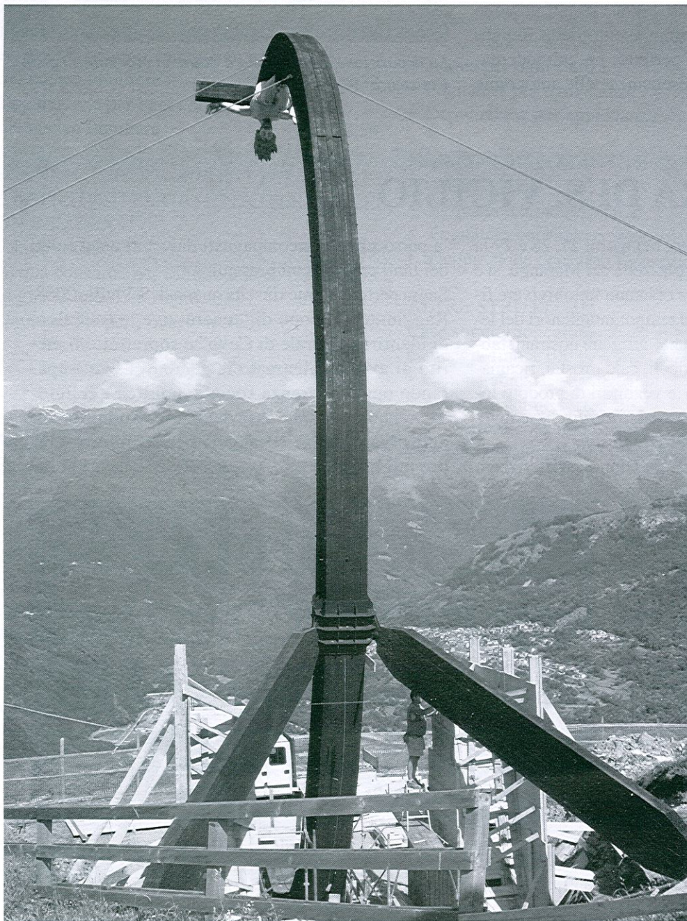
Croce del Papa: costruzione plinti per fissaggio Millenni
