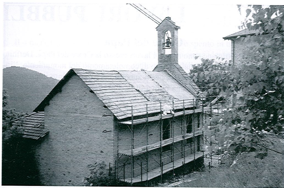
Sistemazione tetto della chiesetta di Villa Ferrari
