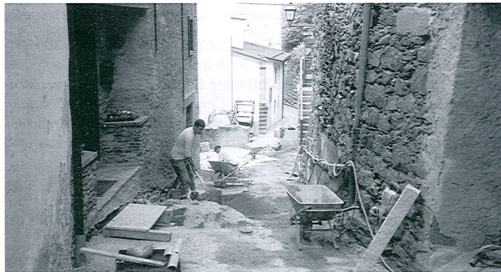
Lavori di pavimentazione in pietra Luserna in via Adamello
