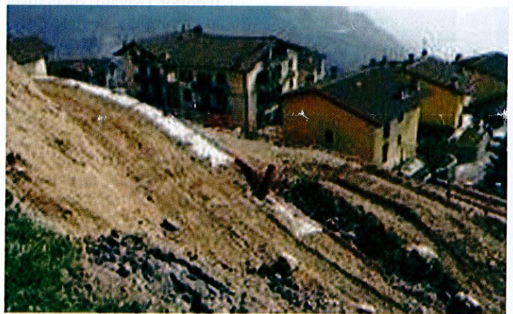
Cevo: Iniziati i lavori all'Androla
