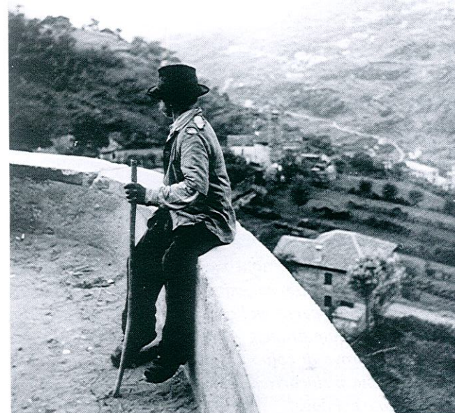
Un viandante di passaggio ad Andrista guarda curioso verso il costruendo Centro Polifunzionale
