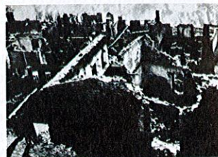
Cevo: L'immagine documenta gli effetti dell'incendio.
