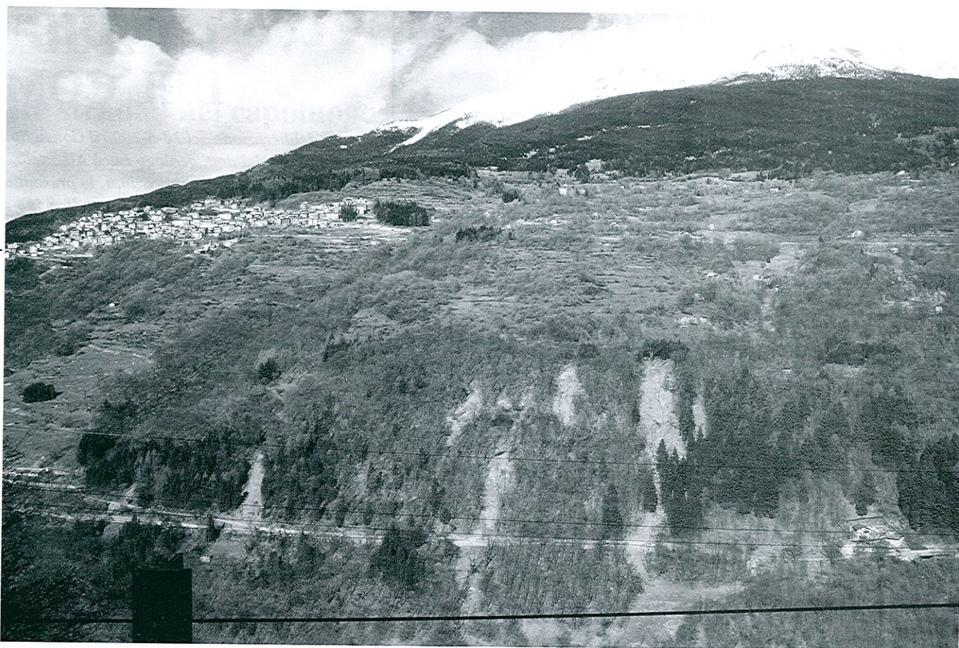
Stillicidio di frane tra Pozzuolo e Ongareda
