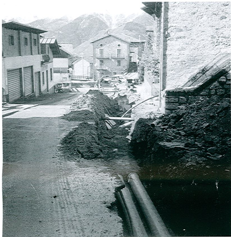
Rifacimento fognatura in via Roma
