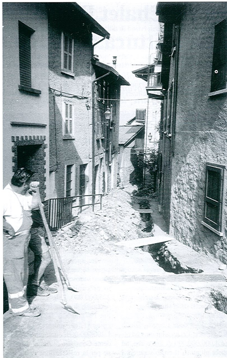
Posa del metanodotto in via S. Vigilio
