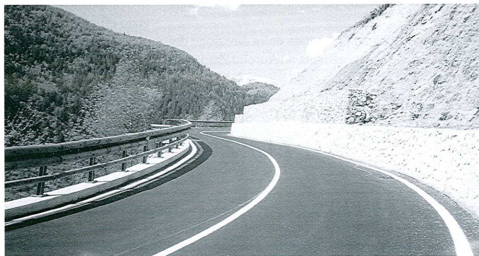
Ripristino strada provinciale n. 6, tra Cevo e Fresine
