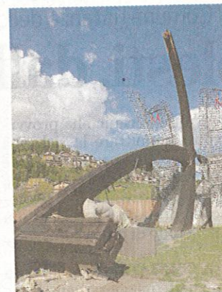
La grande croce crollata a Cevo
