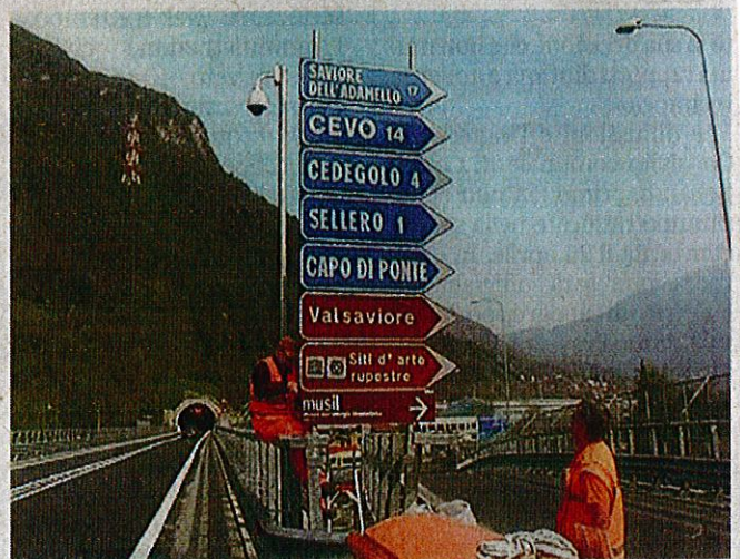
Gli operai all'opera nella posa dei cartelli
