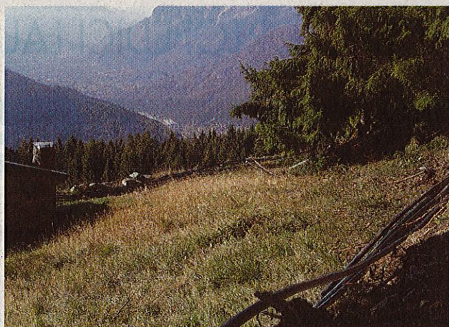
Una parte della rete di tubi stesi per «asciugare» la Valle del Pesce
