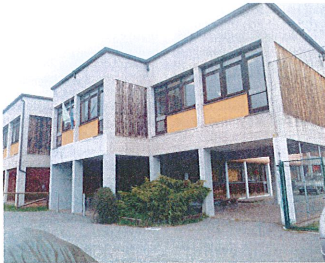
Cevo: L'edificio scolastico che sarà sede del Museo della Resistenza della Valcamonica.
