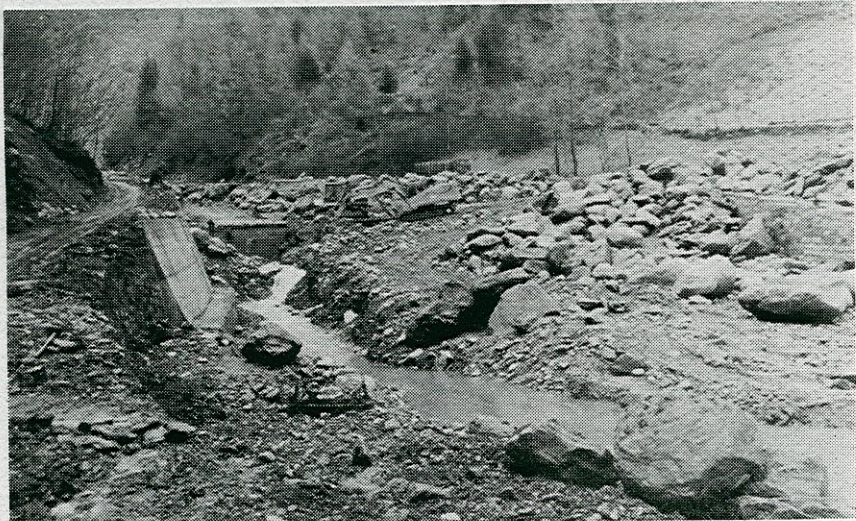
Lavori a monte di Isola Torrente Poia
