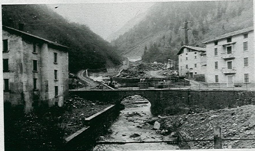
Isola Torrente Poia lavori in corso
