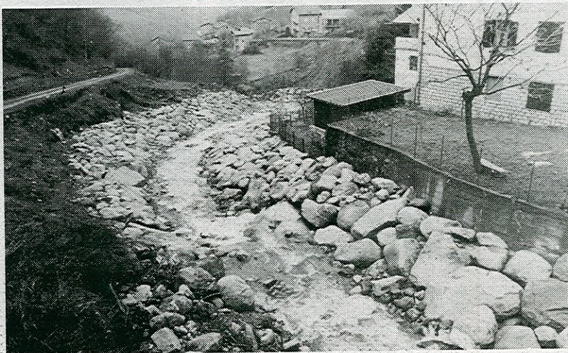
Torrente Salarno. Sistemazione letto e argini del fiume
